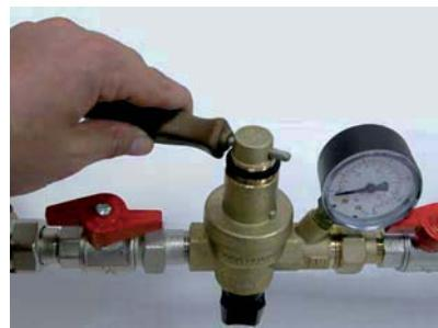
La pressione in uscita può essere facilmente modificata anche una volta che l'apparecchio è installato.
